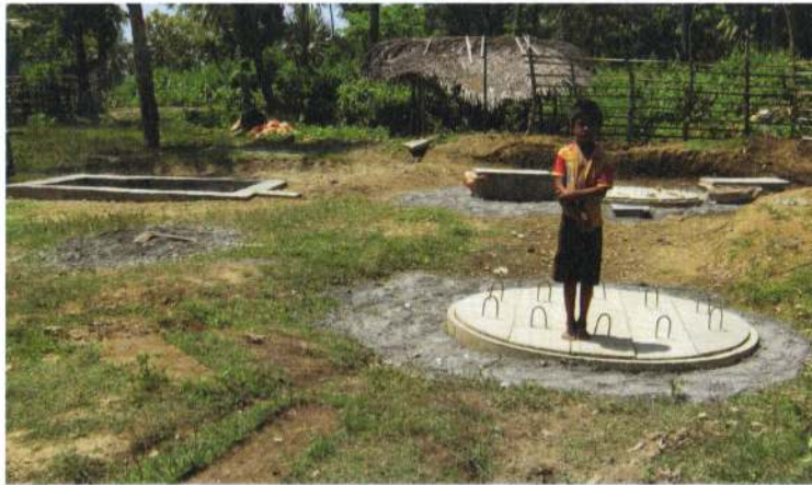
Figura 23 C: Planta de Biogas do sistema PUXTIL
