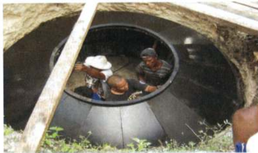
Figura 10: Montagem completa do digestor
