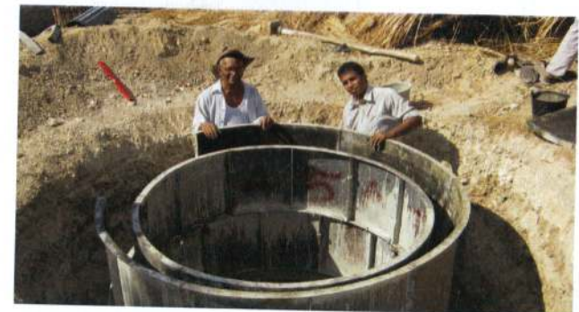
Figura 23B : Montagem do molde exterior
