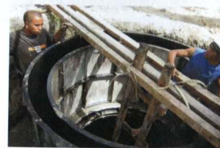
Figura 15:Montagem completa dos moldes do pescoço exterior
